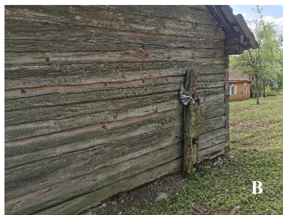
21 pav. Neįrengta nuogrinda ir pakilęs grunto lygis: A – pietvakarių fasadas; B – šiaurės rytų fasadas
