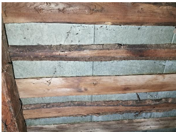
17 pav. Drėgmės paveikta ir nenužievinta mediena
