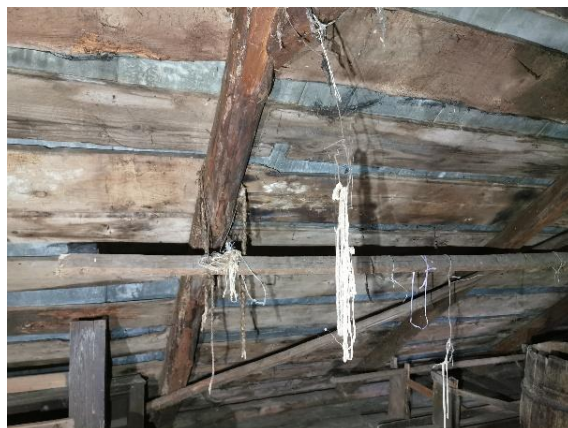
18 pav. Drėgmės paveikta mediena
