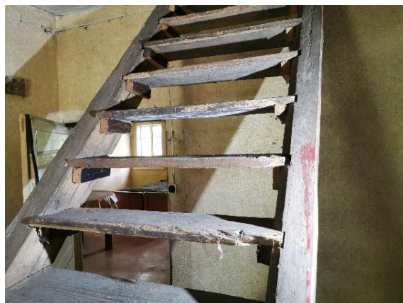
14 pav. Laiptai pažeisti entomologinių kenkėjų
