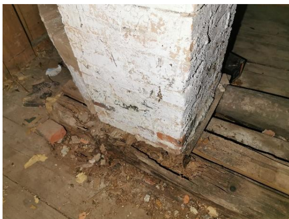
19 pav. Grindų mediena pažeista drėgmės ir puvinio
