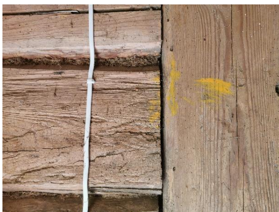
7 pav. Mediena pažeista entomologinių kenkėjų
