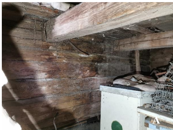
25 pav. Medinės sandėlio konstrukcijos paveiktos drėgmės A ir B
