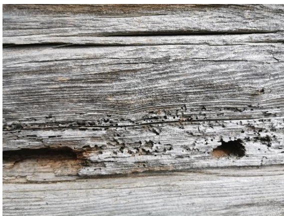
22 pav. Mediena pažeista entomologinių kenkėjų
