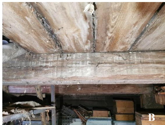
25 pav. Medinės sandėlio konstrukcijos paveiktos drėgmės A ir B
