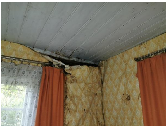
11 pav. Po tapetais pažeista mediena
