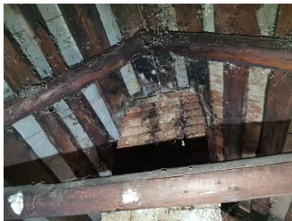
16 pav. Dėl drėgmės atsiradę patamsėjimai, dėmės
