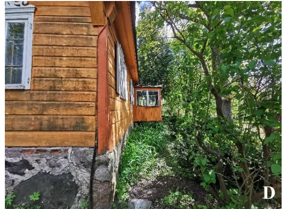
1 pav. Aplink pastatą neįrengta nuogrinda, pakilęs grunto lygis: A – pietryčių fasadas; B – šiaurės rytų fasadas; C – šiaurės rytų ir šiaurės vakarų fasadai; D – pietvakarių fasadas
