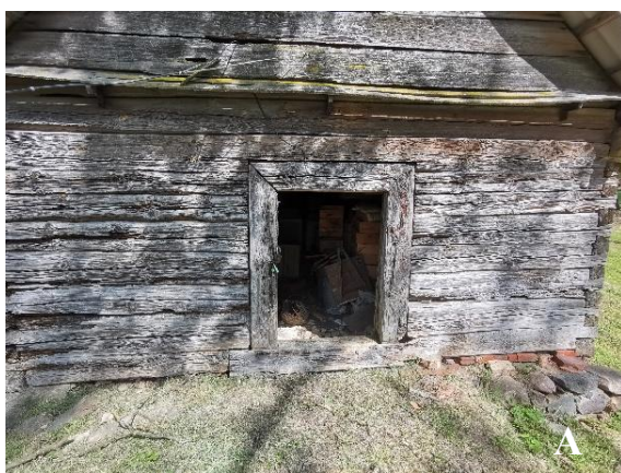
21 pav. Neįrengta nuogrinda ir pakilęs grunto lygis: A – pietvakarių fasadas; B – šiaurės rytų fasadas
