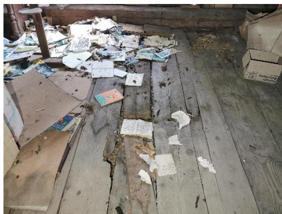
20 pav. Grindų mediena įlūžusi, mėtosi gyvūnų išmatos, šiukšlės
