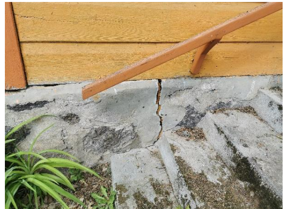
5 pav. Pamato įtrūkimai užtaisyti montažinėmis putomis
