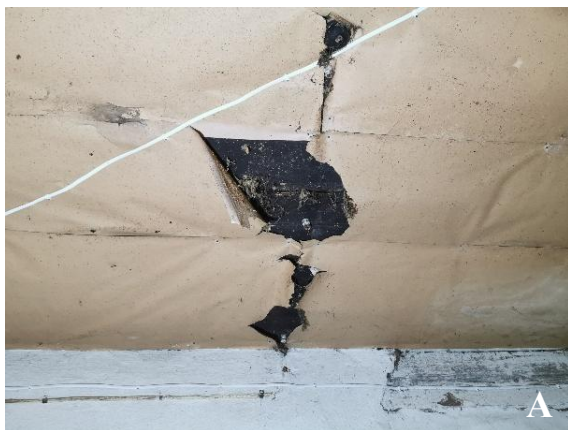
9 pav. Atplyšę lubų tapetai: A ir B
