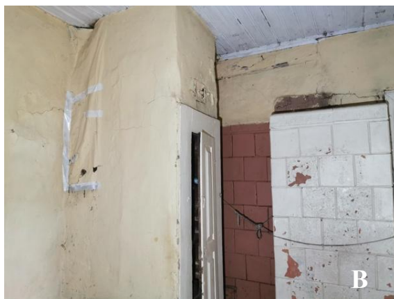
10 pav. Tinko ir dažų pažaidos: A ir B
