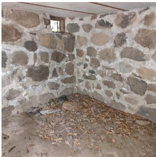
6 pav. Stubos rūšio langelis neuždengtas tinkliuku, ant žemės yra prikritusių lapų sąnašos
